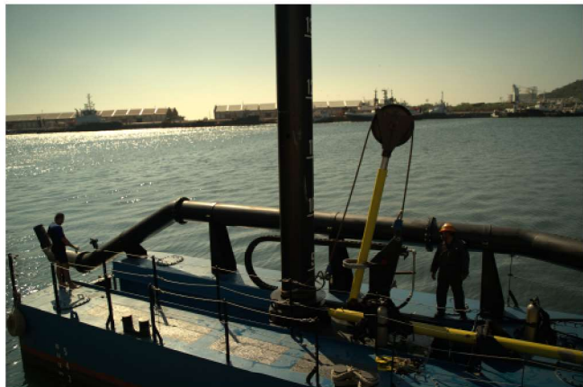
Spud Hoisting System
